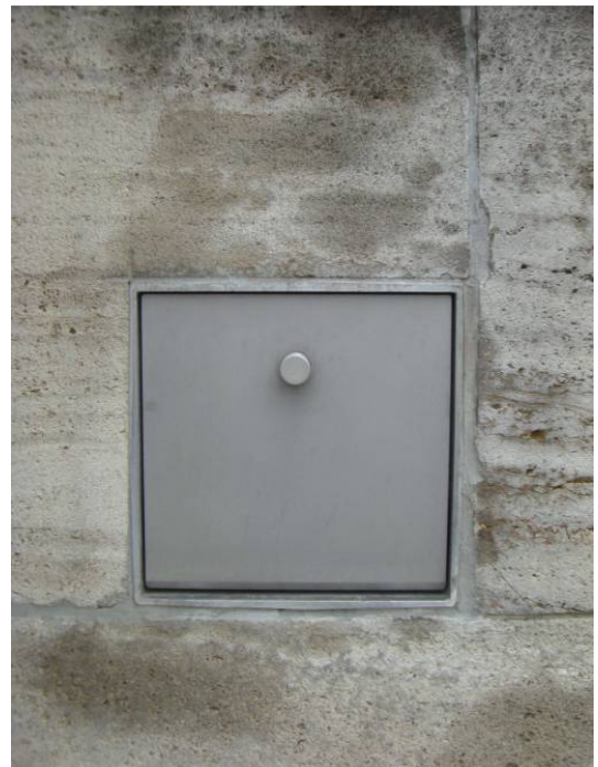
Bild 8: Feuerwehr-Schlüsseldepot
