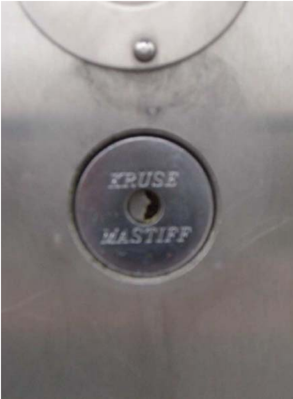
Bild 5: Freischaltelement (verbaut)
